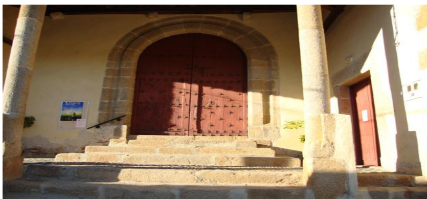
Portada de la fachada meridional de la iglesia
