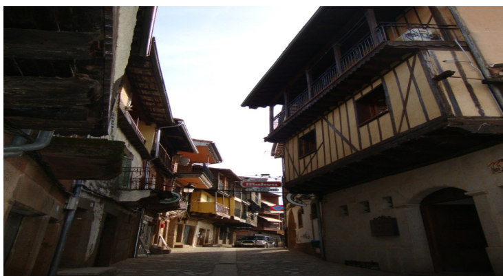
Viviendas entre la Plaza Mayor y la Calle Doctor Requejo
