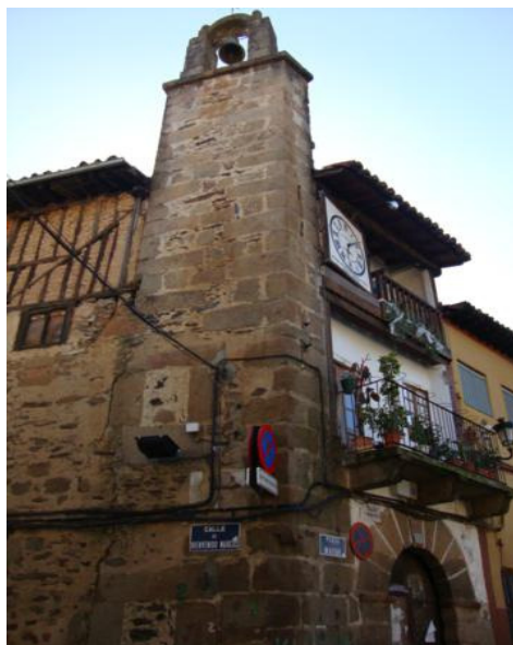
Torre y Casa del Reloj
