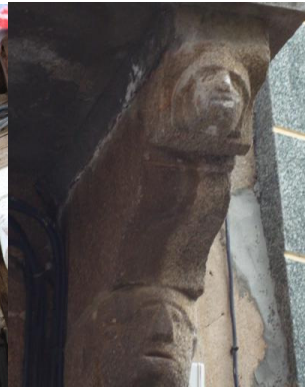
Ménsulas fechadas en 1808
